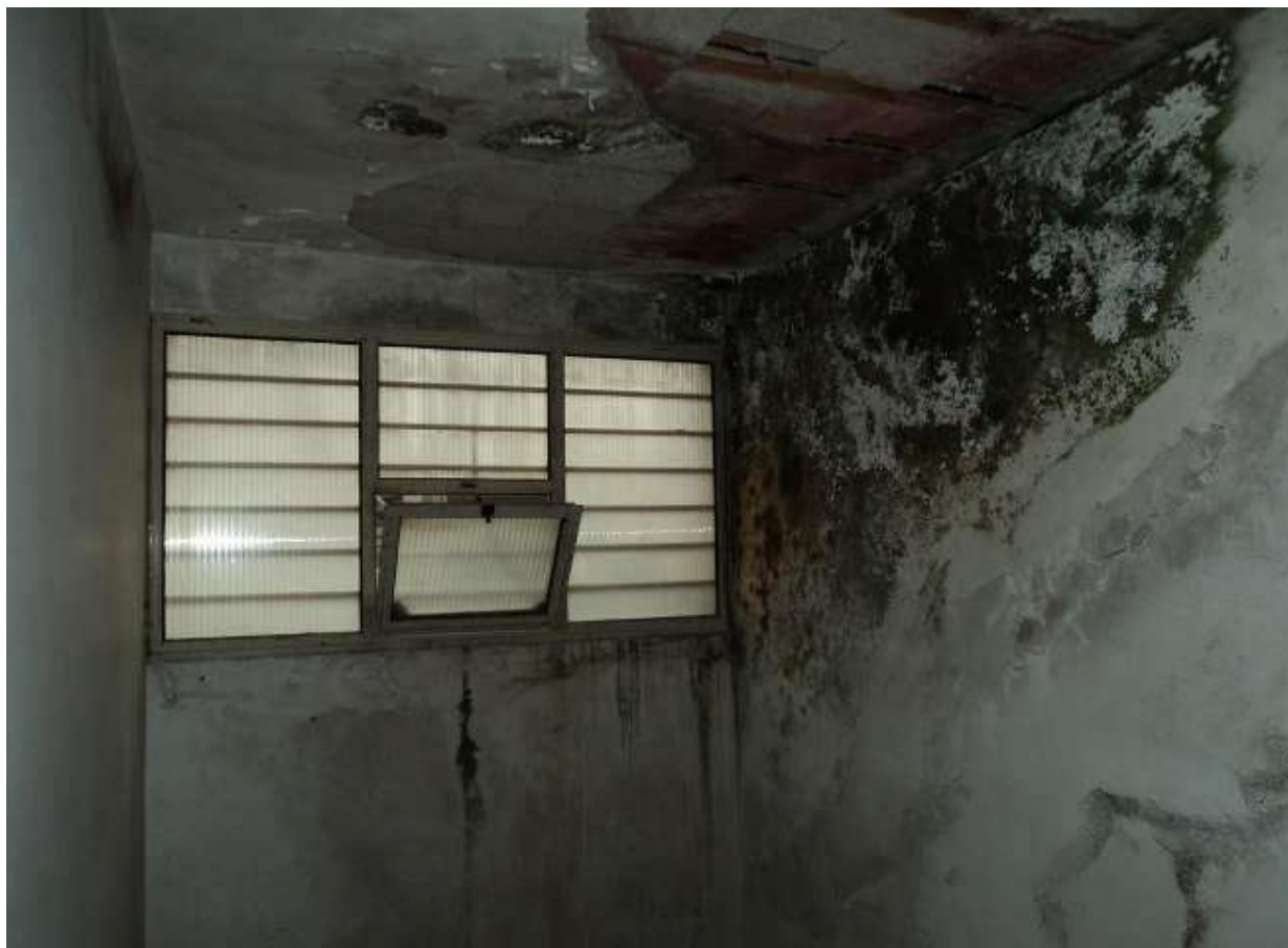
FOTO n° 8: Particolare del degrado delle pareti del vano scala
